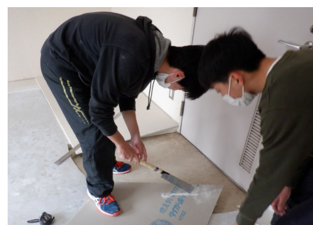
図8：円弧部の施工
