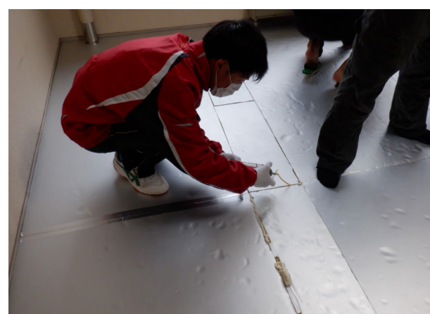
図6：断熱補修
