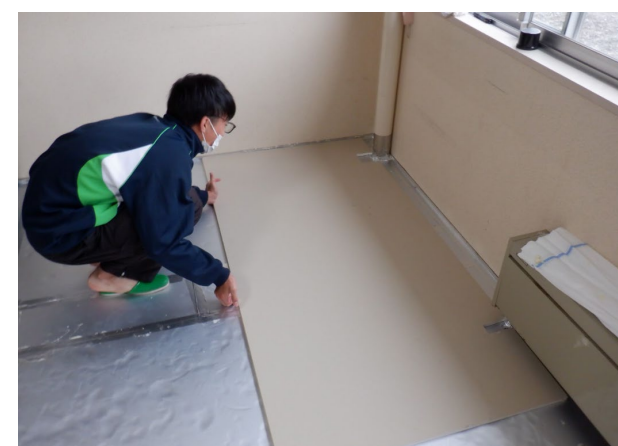
図7：床下地施工
