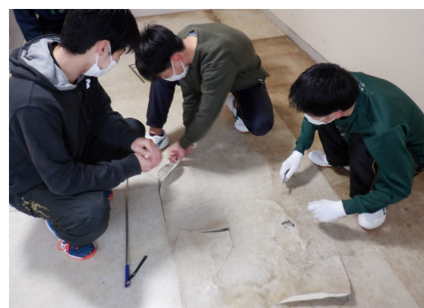
図5：既存不陸箇所の撤去
